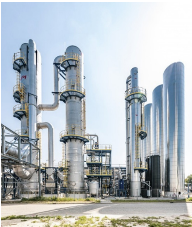
Figure 4 : illustration d'une installation de capture du \text{CO}_2 aux Pays-Bas (centre d'incinération, AVR, Duiven, Pays-Bas, 100 000 tonnes de \text{CO}_2 par an) Source : www.avr.nl
